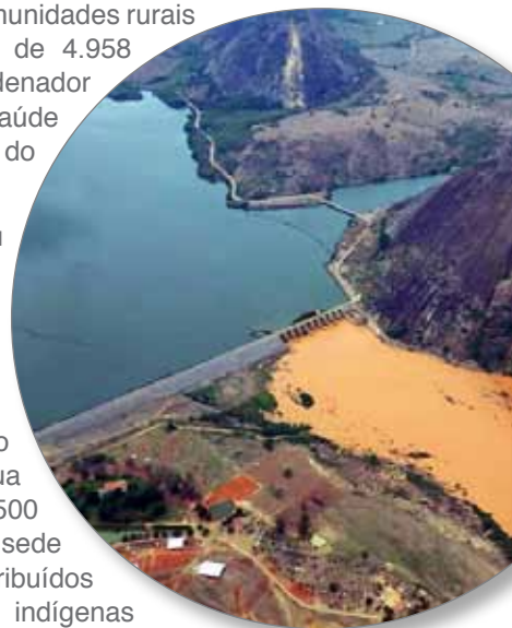
Desastre: lama na divisa entre ES e MG
